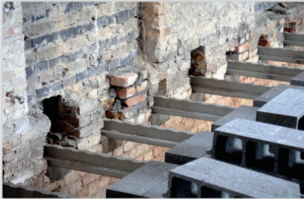
Systemy stropowe RECTOBETON i RECTOLIGHT. Stosowane przy renowacjach. Wymiana stropu charakteryzuje się: łatwością i szybkością montażu, lekkością konstrukcji stropowej – ciężar od 187 kg/m 2 , możliwy montaż bezpodporowy – nawet do 5,5 m, możliwość wykonania wieńca na pierwszym rzędzie pustaków, oparcie belek w gniazdach w ścianach.
