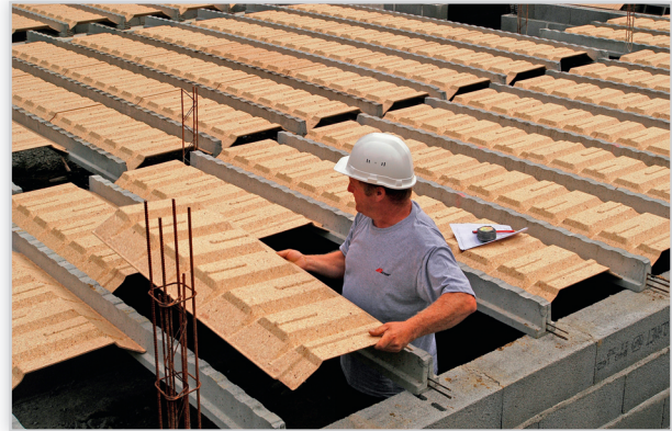
Strop nad przestrzenią wentylowaną. Alternatywne rozwiązanie dla tradycyjnych podłóg na gruncie. Zalety: wentylacja przestrzeni podpodłogowych, eliminacja możliwości popełnienia błędów wykonawczych, zastosowane zamiast tradycyjnej posadzki na terenach gruntów spoistych to rozwiązanie łatwiejsze w wykonaniu i bardziej ekonomiczne.
